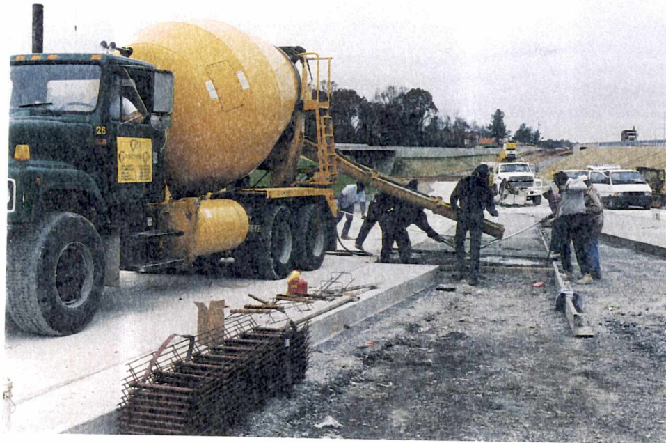
A. POURING CONCRETE
