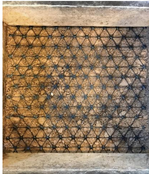
(d) Placement of triaxial geogrid
