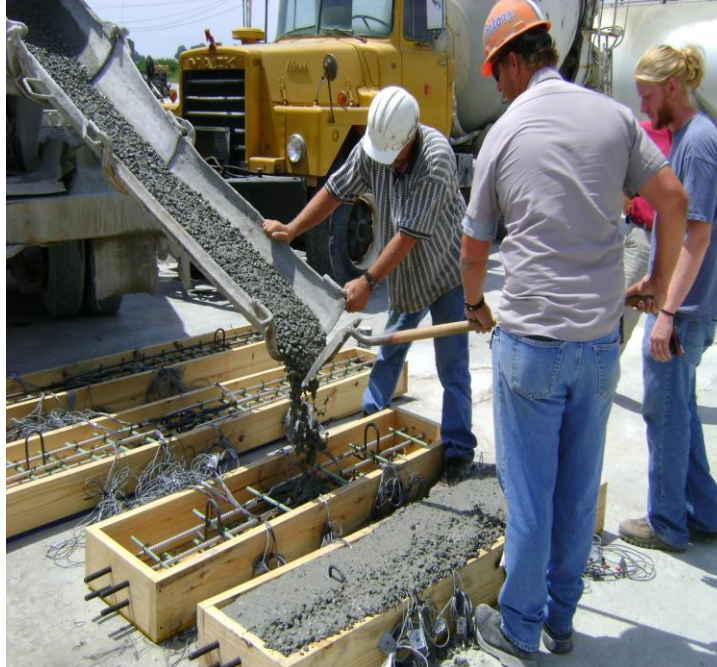
(d) Pouring Concrete
